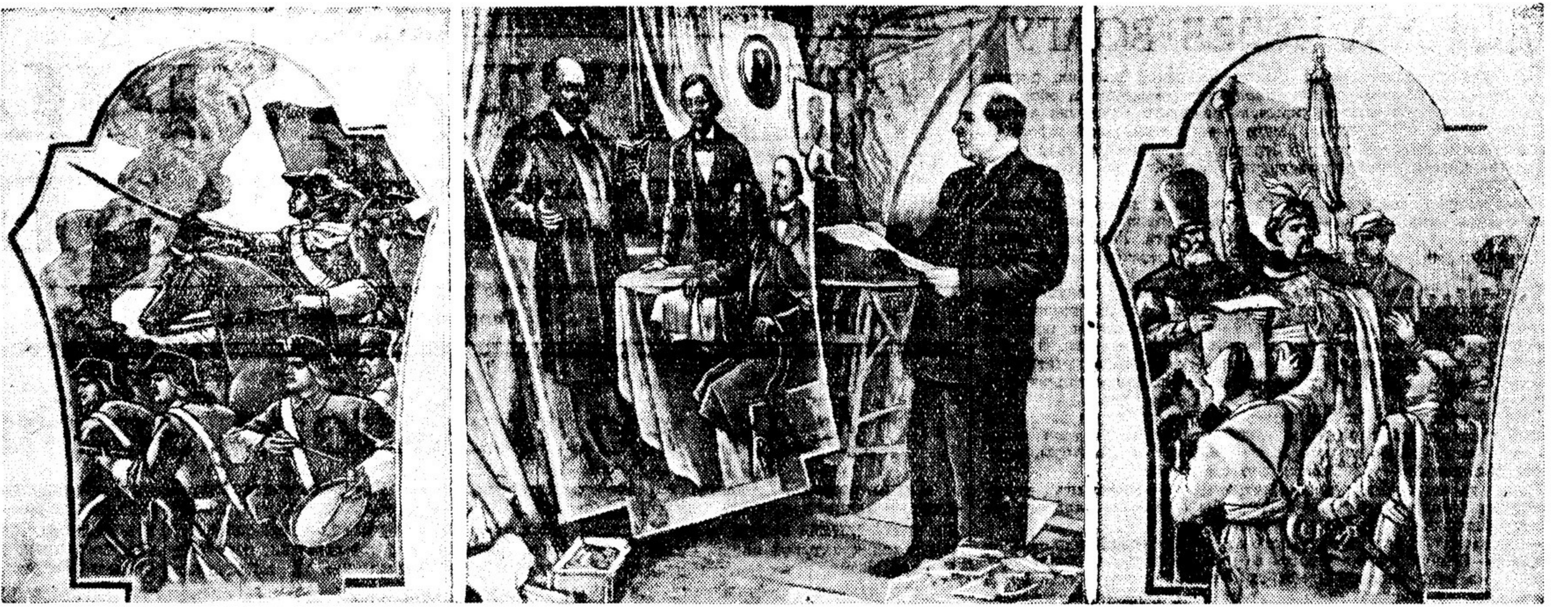
На строительстве Большого кольца Московского метро. Началось оформление центрального зала станции «Киевская». Здесь пассажиры увидят большие мозаичные панно...
